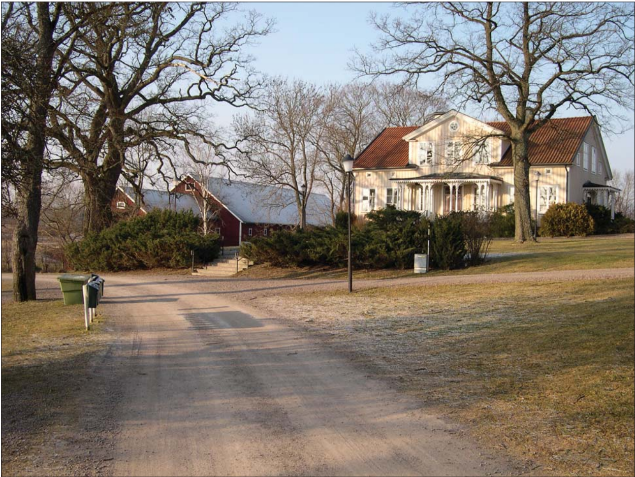
Figur 5. Ledningen sträckte sig från elskåpet söder om den gamla prästgården. Foto Ann-Charlott Feldt, ÖLM.
